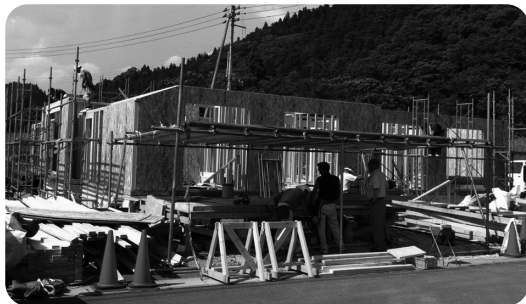
▼ 東新城に建築中のグループホーム
