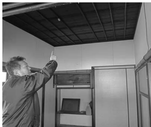
▲松亀園・竹の間の天井の説明をする事務局長の大和田庄治さん
