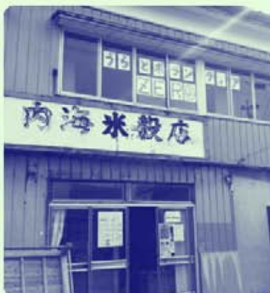
▲桂島にある事務所とボランティアセンター
