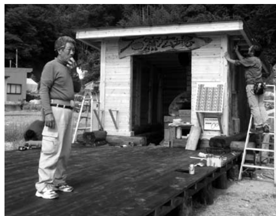
▲相川地区十三浜の仮設住宅集会所前にはウッドデッキも設置しました
